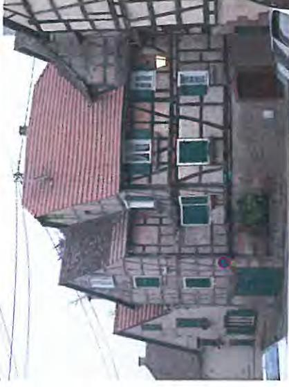
Le pan de bois constitue l'ossature constructive de nombreux bâtiments anciens. Le remplissage traditionnel entre les structures en bois est le torchis (terre et de paille), recouvert d'un enduit protecteur au mortier de chaux.
