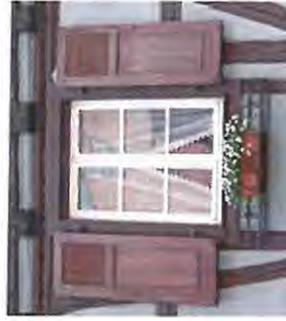
Les menuiseries de type « rénovation », c'est à dire la pose d'un nouveau dormant sur un dormant existant, sont proscrites. Elles réduisent considérablement l'appart de lumière et disproportionnent les rapports pleins / vides (menuiseries/vitrages).
