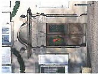
A la fin du XIX<sup>e</sup> siècle, ce système a évolué vers un **seul vantail** travaillé en panneaux avec une partie supérieure qui peut être vitrée et protégée par une grille en fer forgé.
