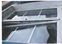
En aucun cas, les petits bois ne seront insérés entre les vitres composant un double vitrage. Les petits bois saillants créent un effet d'ombre, qui disparaît avec la brillance du vitrage et une intégration entre les deux vitres.
