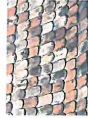
Couverture à simple recouvrement
