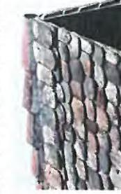
Couverture à double recouvrement
