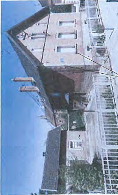
Disparition des modénatures (chainage d'angle, encadrements en grès, bandeau,...) et de la façade en briques apparentes
