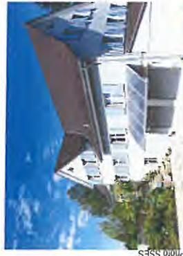
Capteurs posés dans le plan de la toiture d'une véranda ou servant d'auvent
