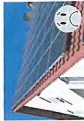
Les panneaux solaires sont mis en place **directement sur les chevrons, afin d'améliorer l'épaisseur des panneaux sur le toit.**
