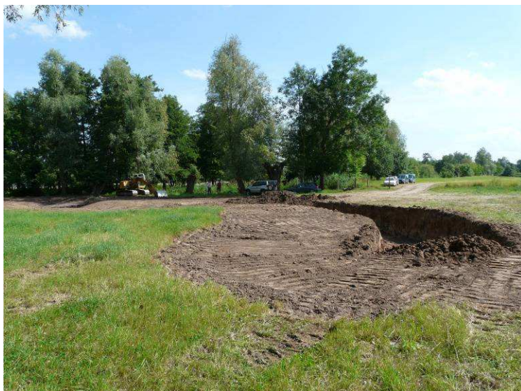
Travaux en cours : 18/6/2009
