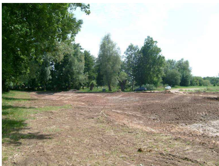
Nivellement aval terminé : 29/06/2009
