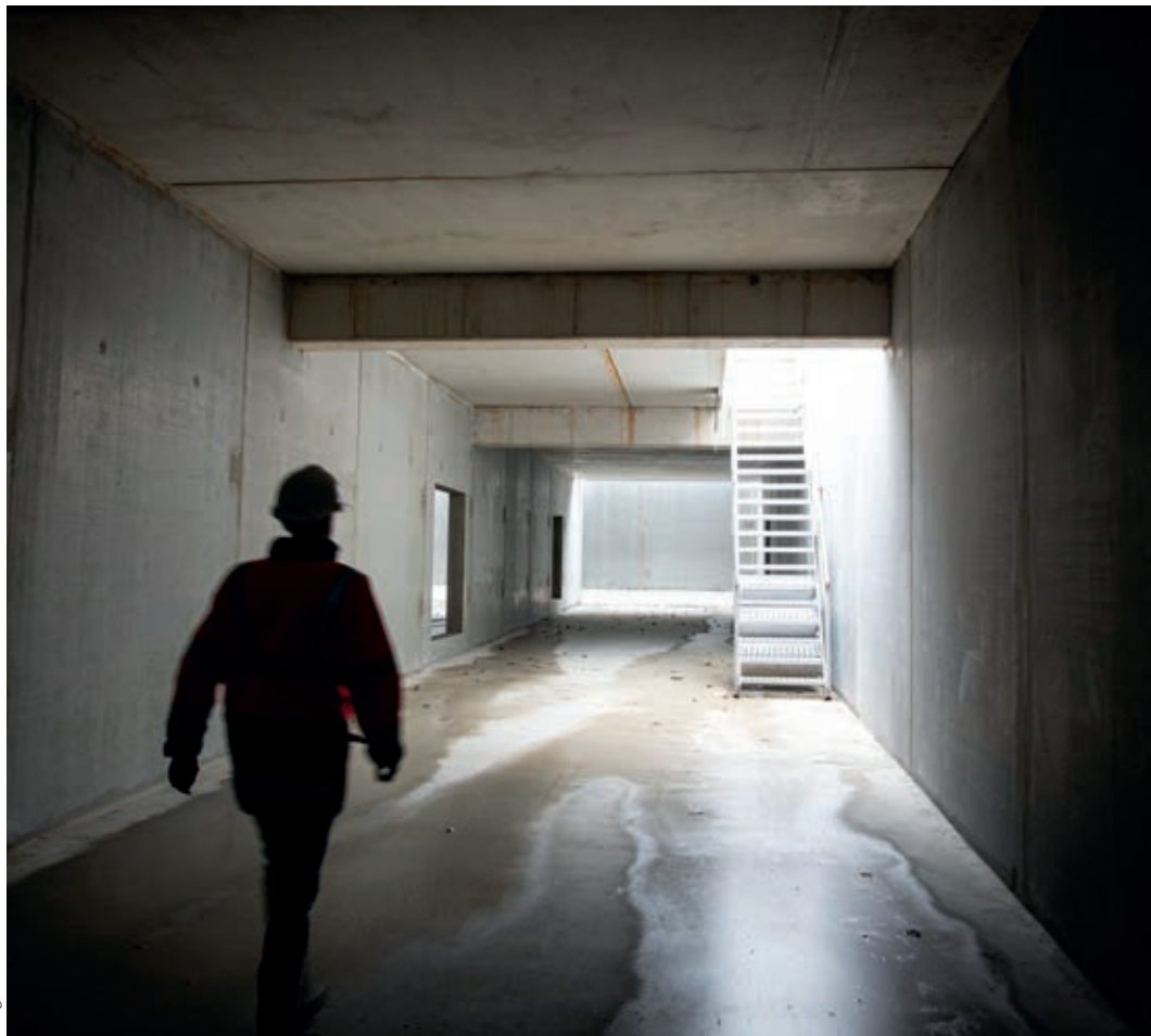
L'ouvrage retiendra les eaux d'orage avant leur renvoi vers le réseau d'assainissement.
