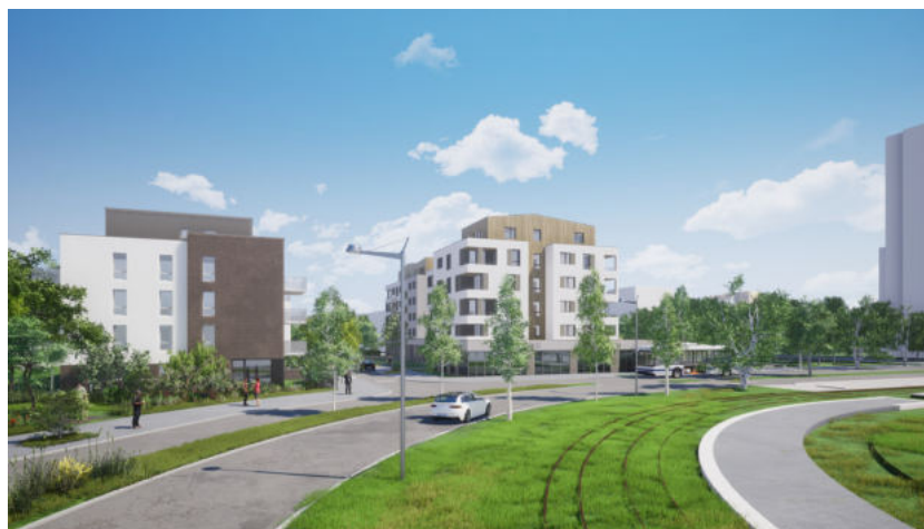
Le projet immobilier « Impulsion ». Crédit : K&+ architecture globale et MB Architectes
