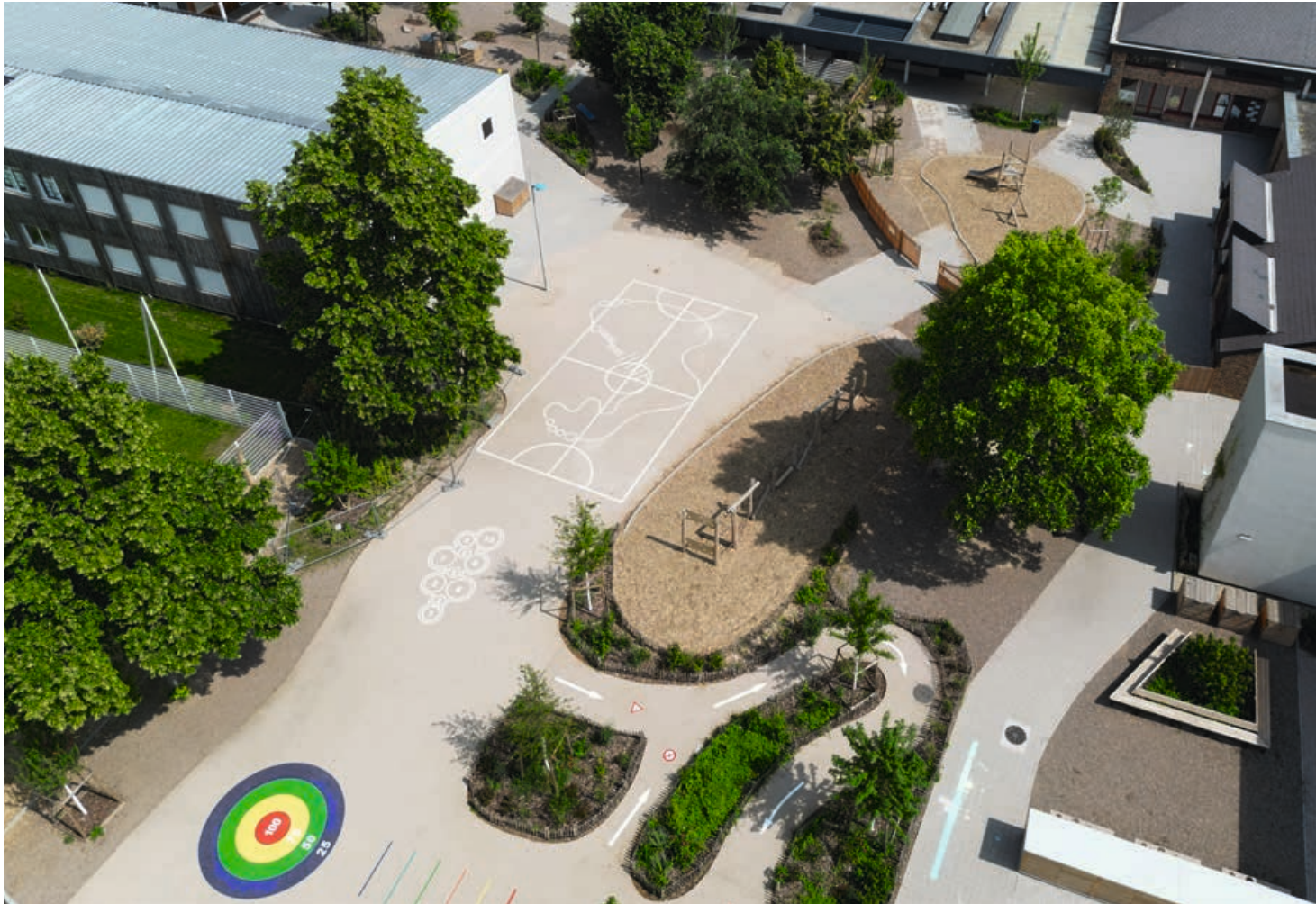
Aux Poteries, 40% de la surface de la cour de l'école Gustave-Stoskopf ont été déminéralisées. ©VILLE ET EUROMÉTROPOLE DE STRASBOURG
