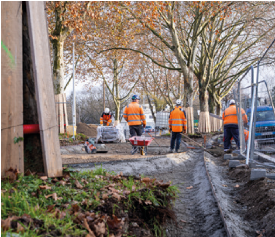
L'aménagement des abords du stade se poursuivra jusqu'à fin 2026. ©E. CEGARRA
