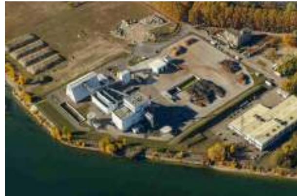
Chaufferie collective biomasse du Port du Rhin
