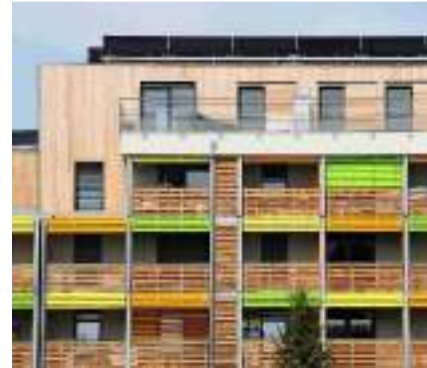
Installations de production énergétique sur toiture
