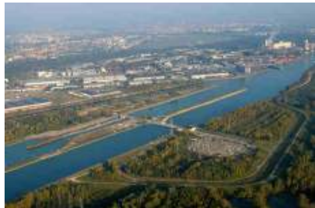
Barrage hydroélectrique sur le Rhin
