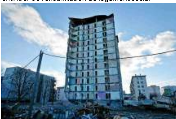
Chantier de démolition / reconstruction
