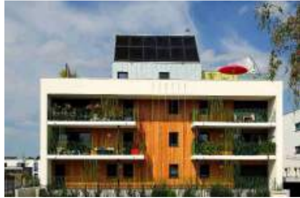
Construction intégrant des solutions photovoltaïques
