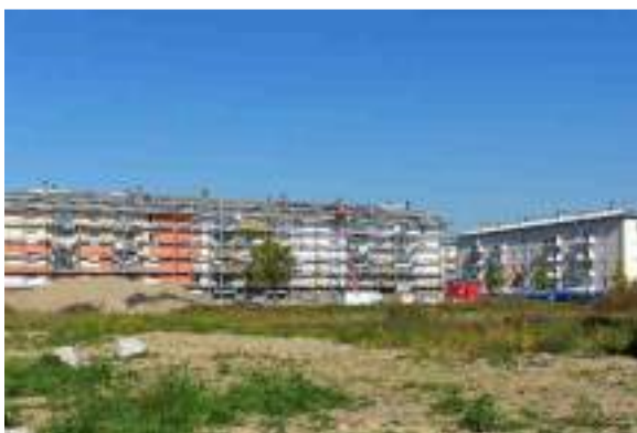
Chantier de réhabilitation de logement social
