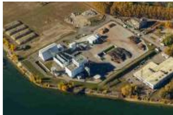
Chaufferie bois du Port du Rhin
