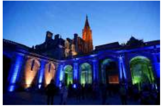
Éclairage des bâtiments et espaces publics
